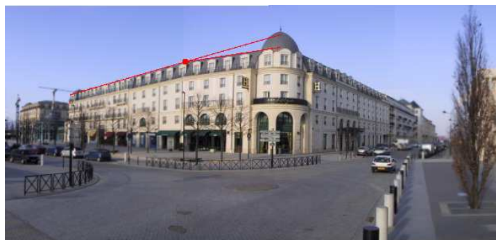
Observer la cassure de la ligne de fuite au niveau du toit gauche.
